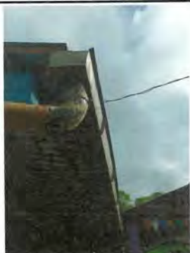
Foto 5: Se observa los canales de agua en deterioro del módulo 2
