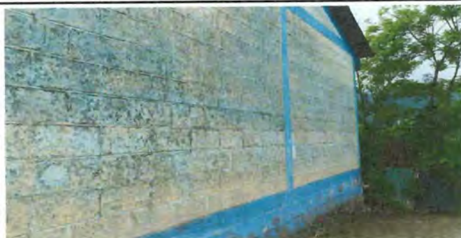
Foto 6: Se observa el deterioro de las pinturas de la parte exterior de los módulos 1,2,3 y 4
