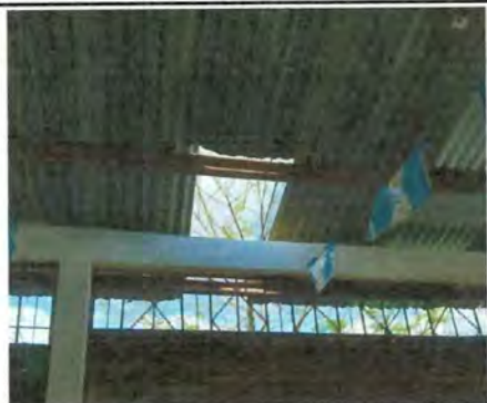
Foto 1: Se observa el deterioro del techo de las aulas del módulo 3 y 1 aula del módulo 4.
